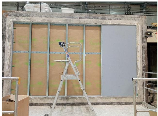
Mise en œuvre des plaques de parement
