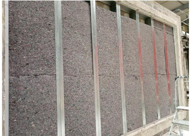
Mise en œuvre de l'ossature et de l'âme
