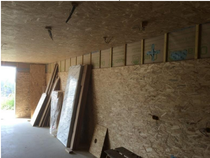
RdJ - OSB non posé pour contrôles
