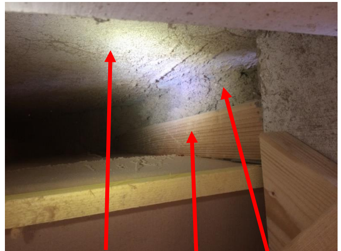
Mur existant – MOB - Ouate insufflée
