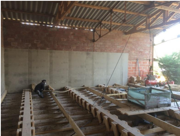
Insufflation des caisson par la lisse haute
