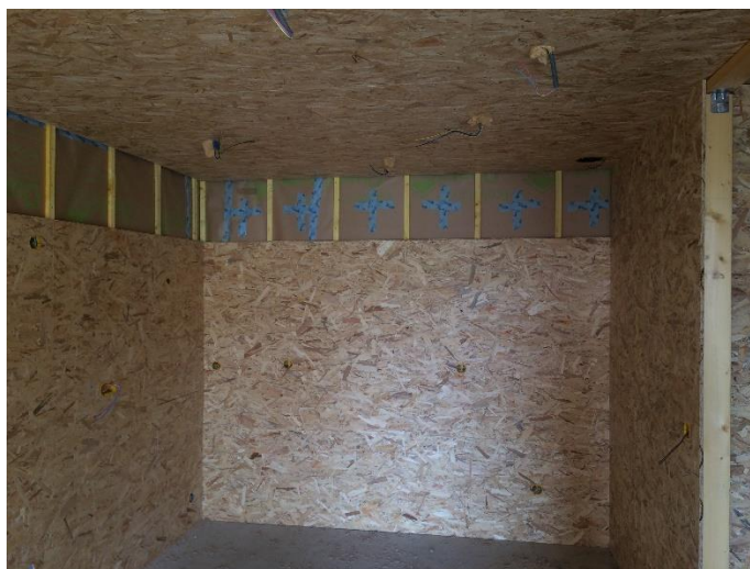
Paroi après insufflation
